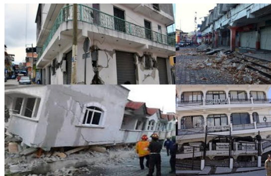
Figura 4. Ejemplo de daños ocasionados por terremoto o sismos en edificios construidos con mampostería de concreto en San Marcos. En este caso la calidad de los bloques afectó la resistencia de la construcción. Fuente: Wikipedia enciclopedia libre.
