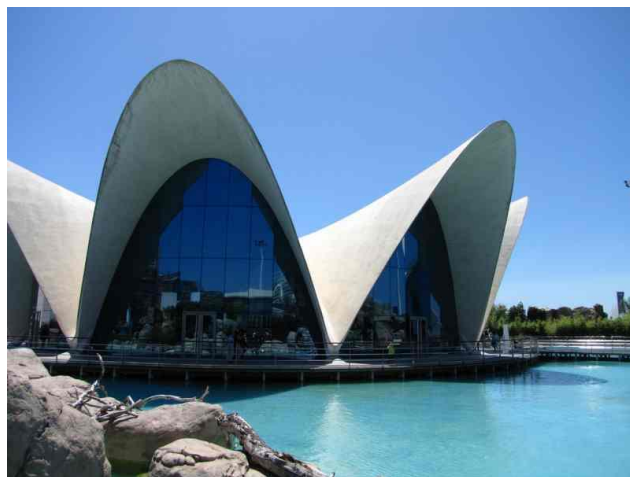
Figura 28. Estructura Continua. Edificio OCEANOGRÁFIC, Ciudad de las Artes y Ciencias en Valencia, España. Fuente: (Plago, 2010)
