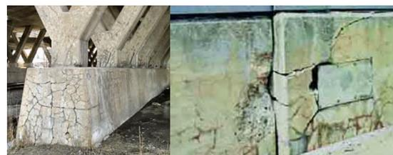
Figura 3. Ejemplo de agrietamiento, exposición de gel y desprendimiento de partes del concreto de la estructura. Fuente PCA<sup>1</sup>.
