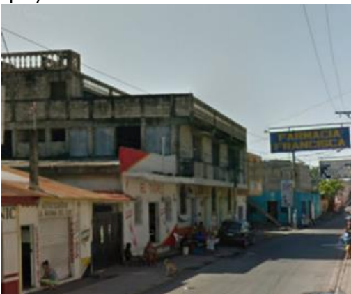
Figura 5. Ejemplo de construcción en zona urbana del Puerto de San José. Fuente: ICCG.
