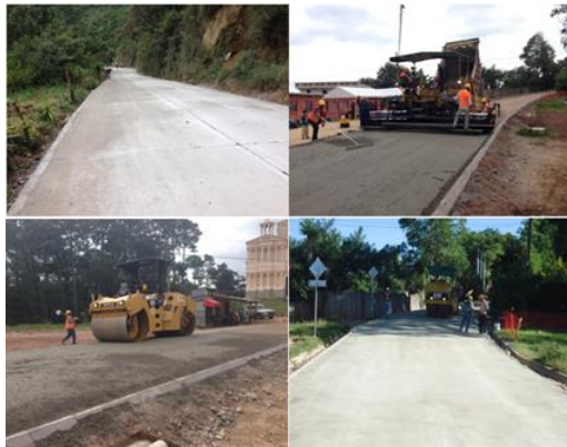
Figura 4. Concreto compactado con rodillo Asunción Chivoc. Fuente: ICCG.
