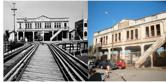
Figura 6. Antiguo muelle del Puerto de San José con deterioro avanzado de la estructura de concreto. Fuente: Wikipedia, Fundación Wikimedia Inc.
