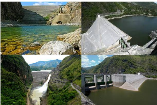
Figura 9. Hidroeléctrica Chixoy, ejemplo de concreto masivo. Fuente: Ministerio de Energía y Minas Guatemala, Hemeroteca Prensa Libre.
