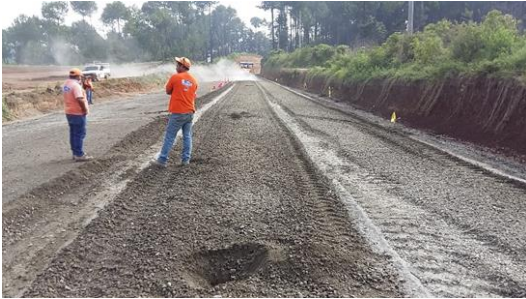
Figura 3. Estabilización de base con cemento. Fuente: ICCG.
