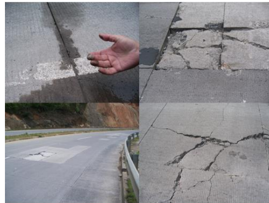
Figura 4. Ejemplo de bombeo y fractura del pavimento Ruta CA-1 Occidente. Fuente: ICCG.
