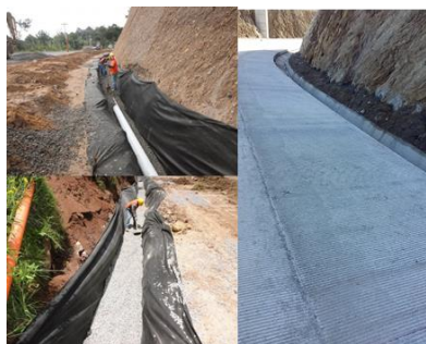
Figura 5. Ejemplo de subdrenaje y drenaje superficial (Cunetas). Fuente: ICCG.
