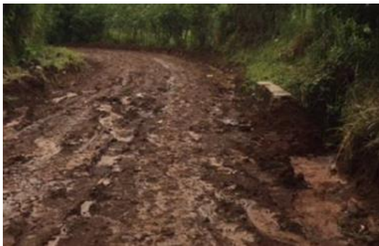
Figura 3. Suelo expansivo en un camino rural Génova Costa Cuca, Guatemala. Fuente: Ing. Hugo González. C&D CETEC.
