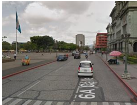
Figura 2. Pavimento antiguo en servicio en la Ciudad de Guatemala. Fuente: Google Maps.
